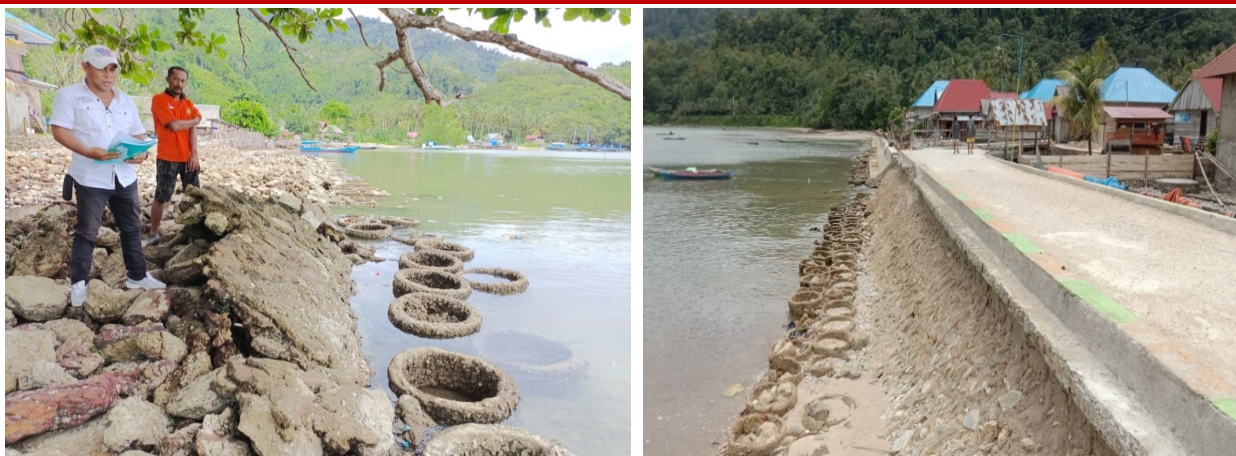
Gambar 4. Bangunan Pemecah Gelombang dan Batuan Pemecah Ombak (EA-2)
